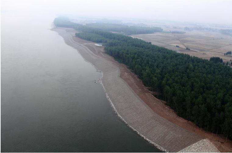
图 4-9 2011 年竣工的长江中游藕池口航道护岸工程
