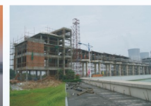
望亭水利枢纽更新改造工程
